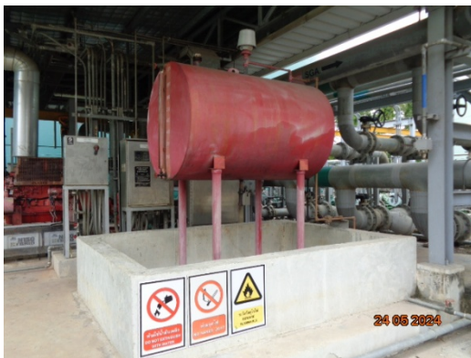
รูปที่ 51 ถังเก็บน้ำมันดีเซล สำหรับจ่ายให้กับ Fire Pump
