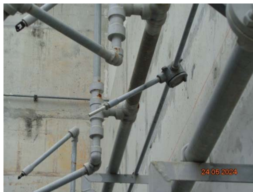
รูปที่ 33 Heat Detector
