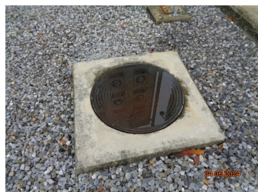
รูปที่ 8 ถังบำบัดน้ำเสียสำเร็จรูป
