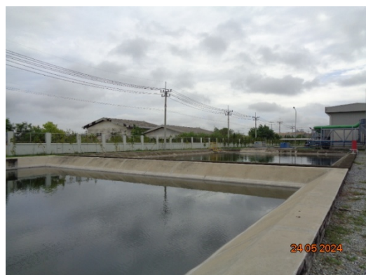
รูปที่ 11 บ่อพักน้ำทิ้งขนาด 800 ลูกบาศก์เมตร
