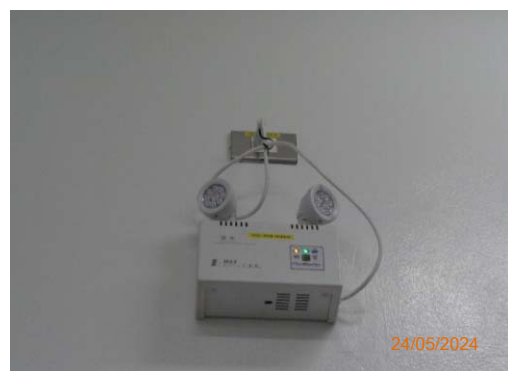
รูปที่ 35 Emergency Light System
